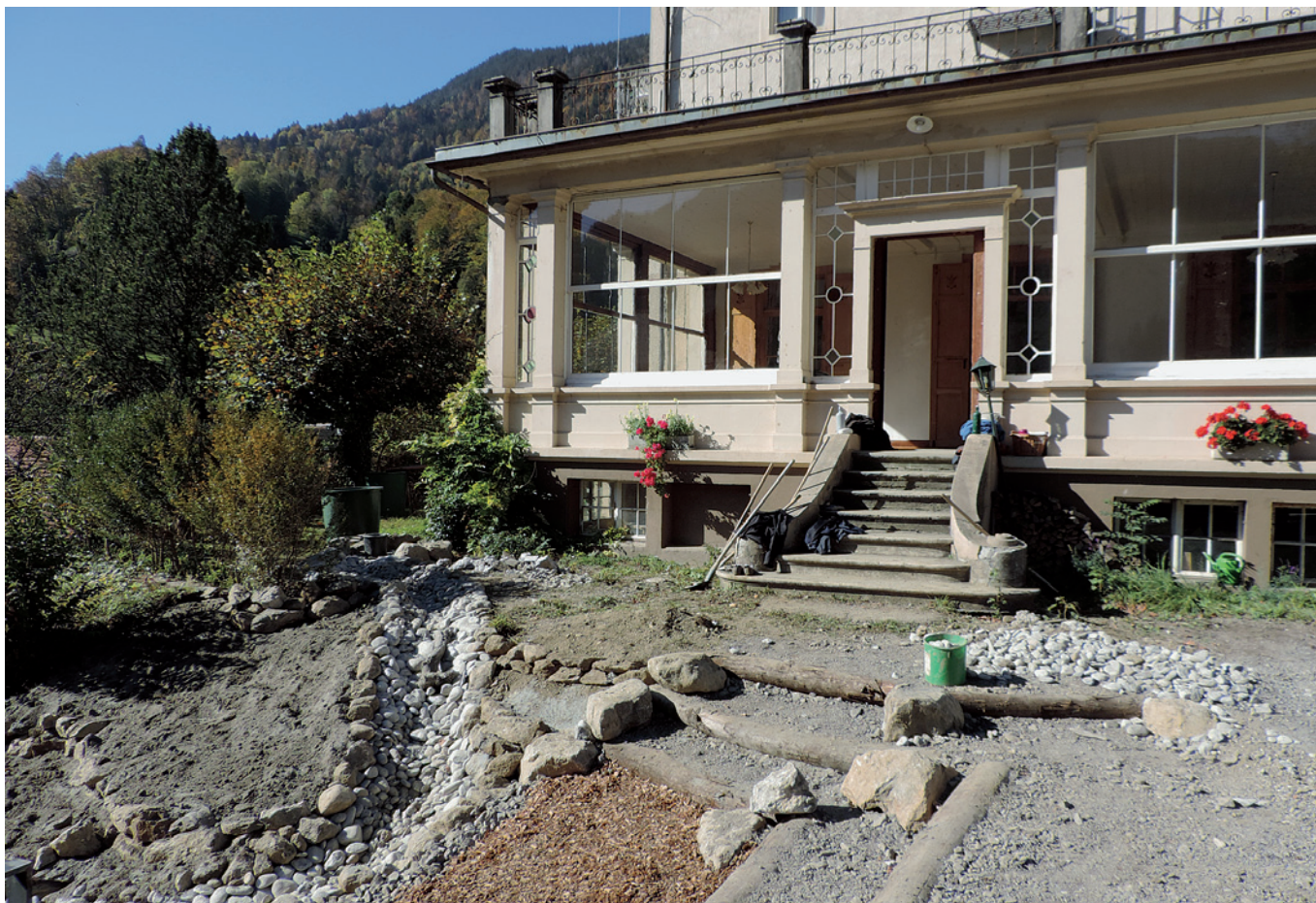
Hoteleingang mit Permakulturanlage im Entstehen
